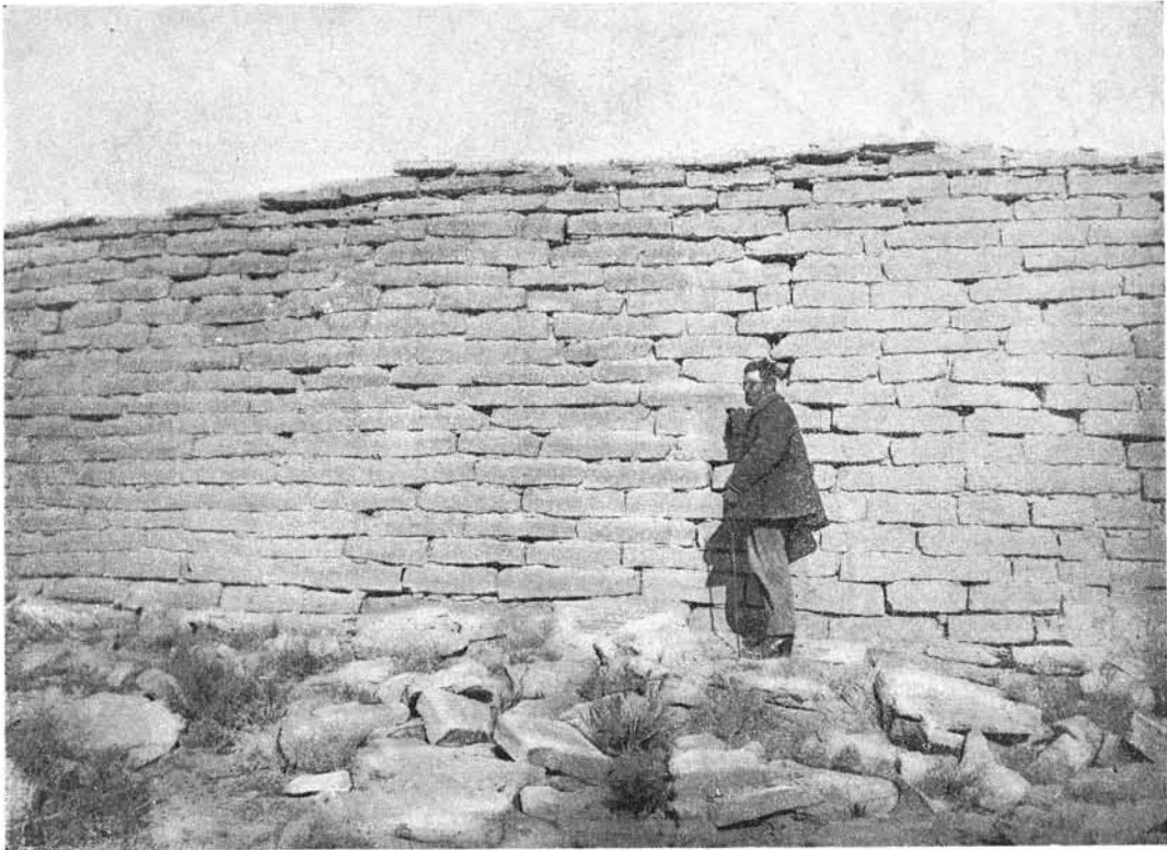
Дэу-кала. 1. Общий вид. 2. Кладка стены,
